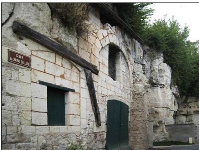
*On voit un important travail de consolidation par des barres ancrées dans le roc et, en haut de la photo, des filets.*
